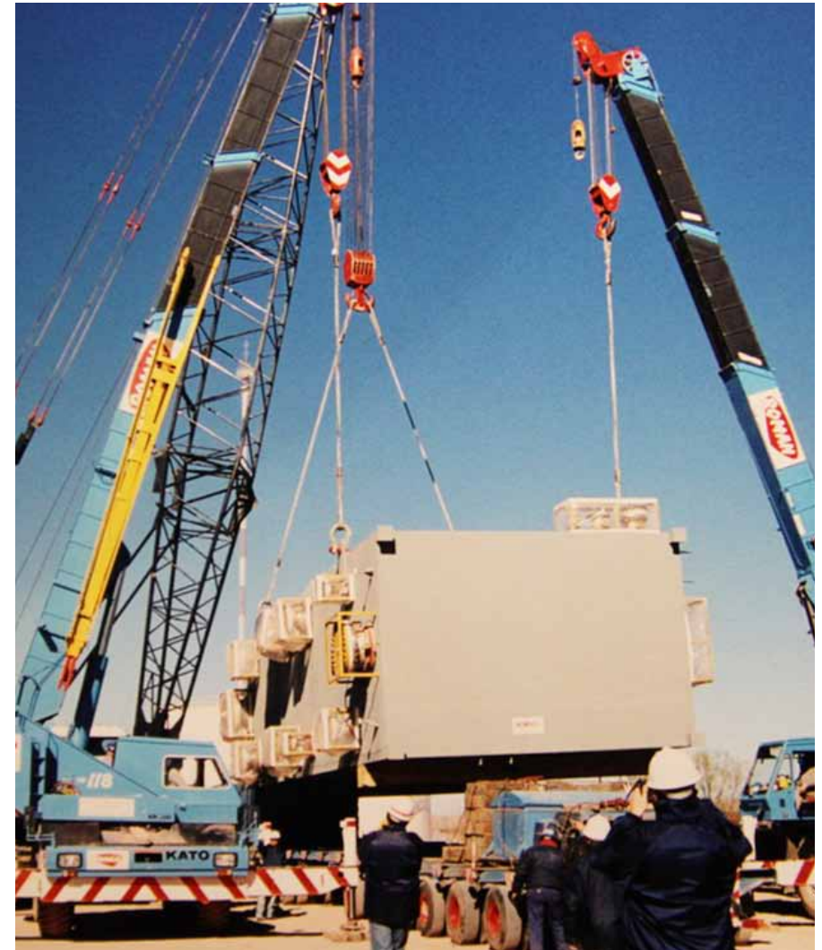
NEUQUÉN PROYECTO MEGA IZAMIENTO DE UNA PLANTA DE TRATAMIENTO DE AGUA
