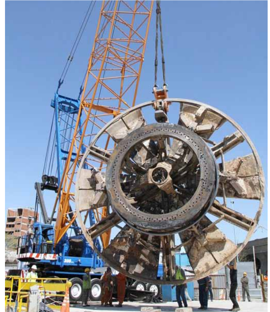
IZAJE Y MONTAJE DE COMPONENTE PARA TUNELERA.
