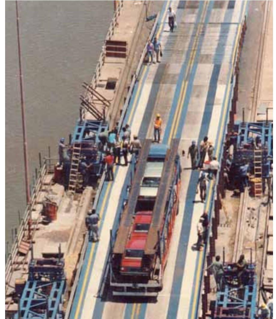
PUENTE GRAL. M. BELGRANO: SU REPARACIÓN, PERMITIENDO EL TRÁNSITO CON NUESTRO SOBREPUNTE MODULAR.
