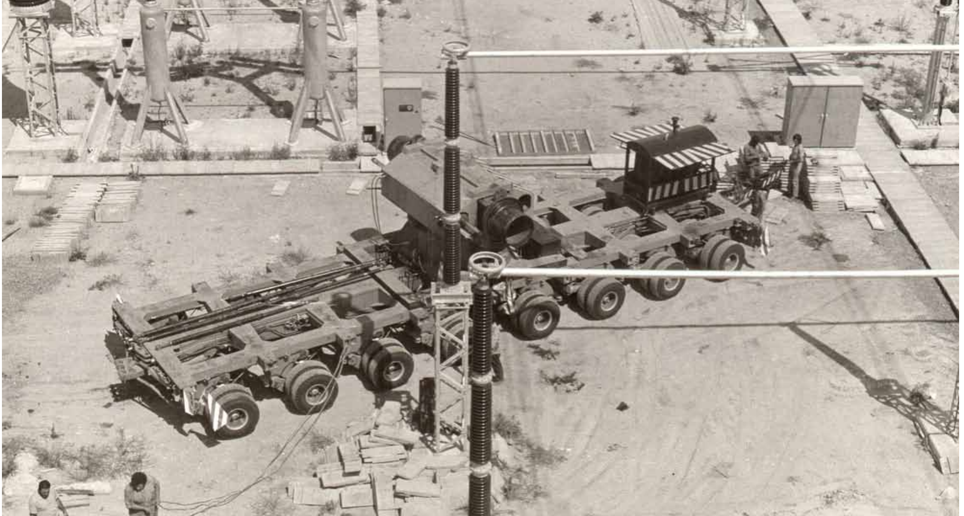
BUGGY HIDRÁULICO OPERANDO
