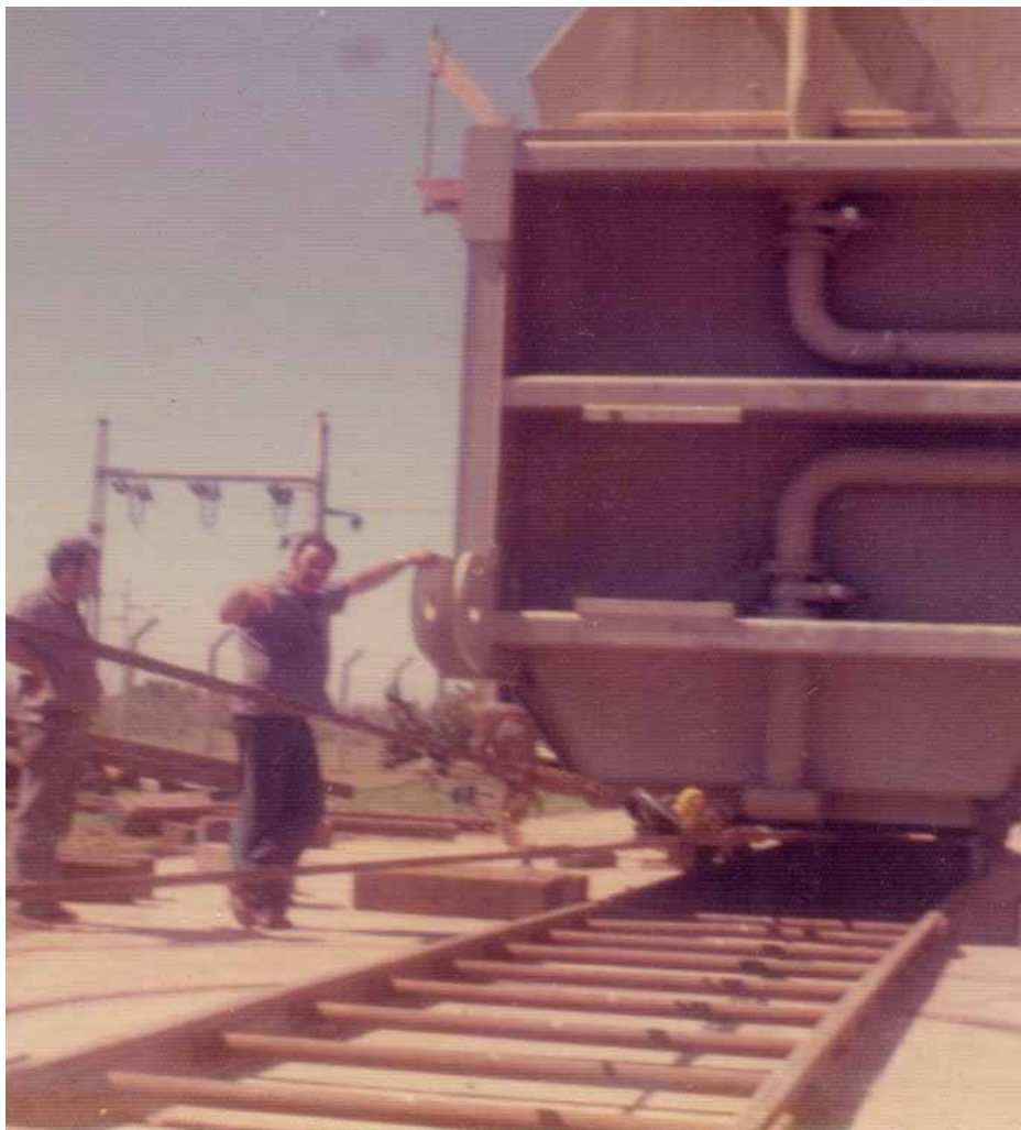
EMPLAZANDO TRANSFORMADORES DE SIEMENS
