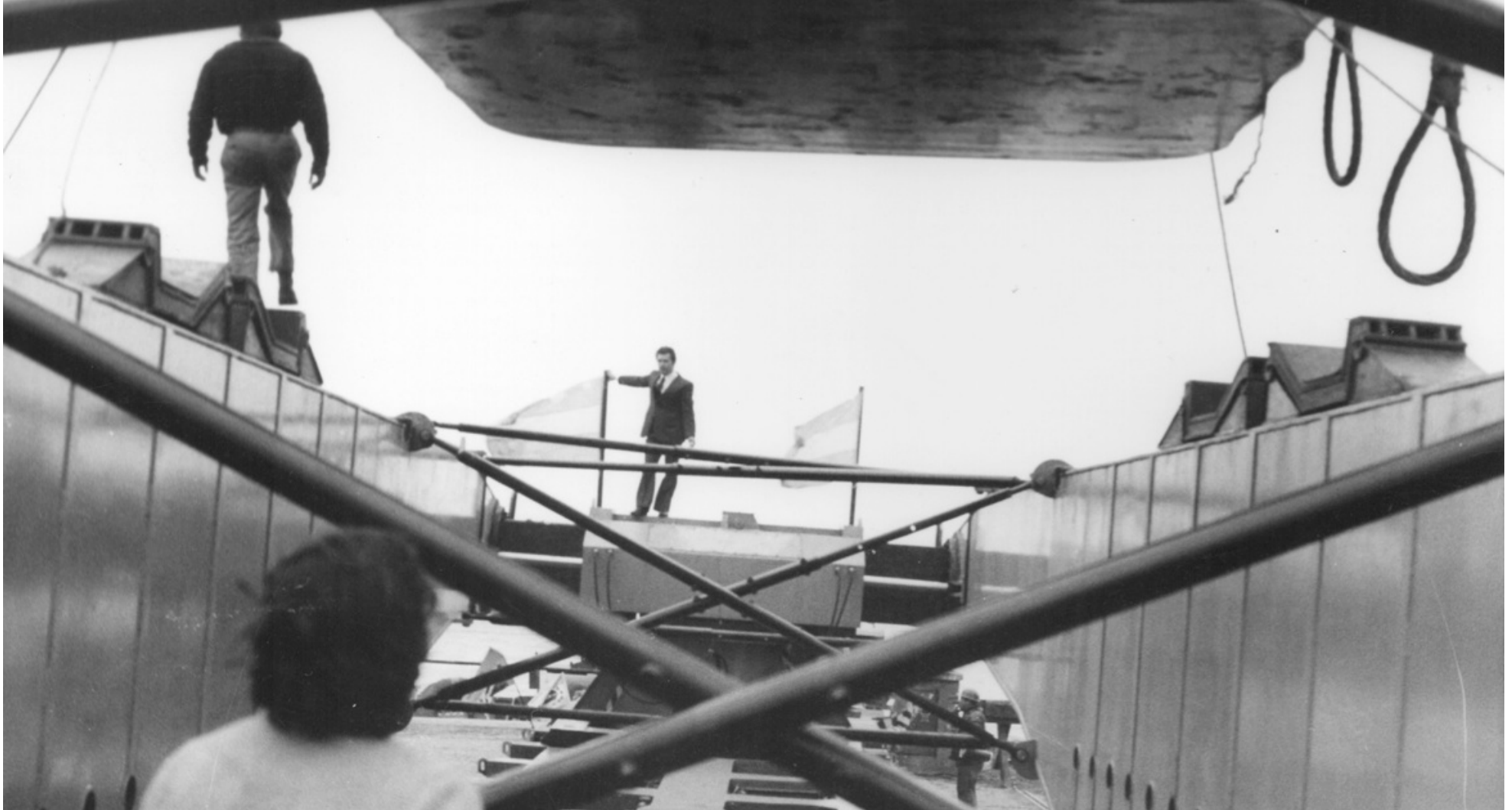
ROMÁN EN EL FONDO CON TRAJE Y CORBATA SUPERVISANDO LA CARGA DE UN TRANSFORMADOR
